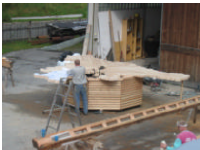
Die Tischplatte ist aus 80 mm starken Massivholz-Elementen angefertigt worden Und hat ein Ausmaß von ca. 550 cm x 450 cm.
