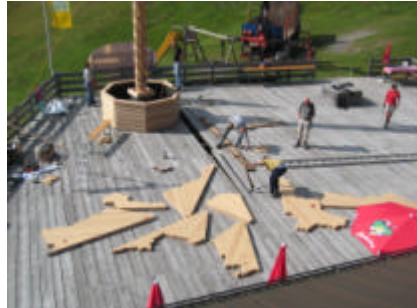
Die Tischplatte ist aus 80 mm starken Massivholz-Elementen angefertigt worden Und hat ein Ausmaß von ca. 550 cm x 450 cm.
